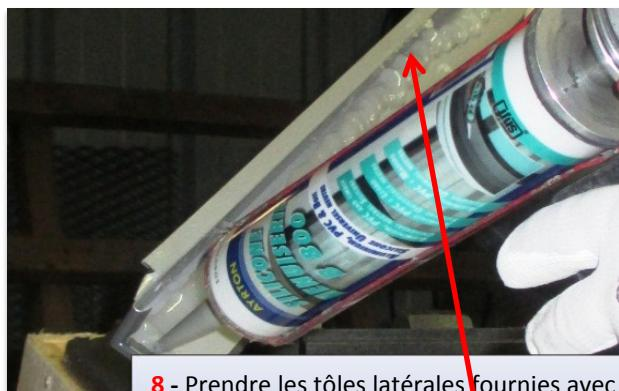
**8 - Prendre les tôles latérales fournies avec le kit d'étanchéité de la fenêtre de toit et poser un cordon de mastic polyuréthane sur toute sa longueur (face qui sera en contact avec le kit, épaisseur 5 mm minimum)**
