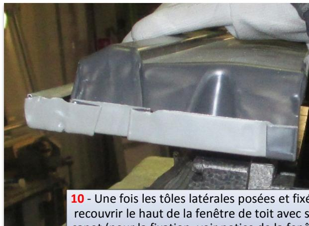
**10** - Une fois les tôles latérales posées et fixées, recouvrir le haut de la fenêtre de toit avec son capot (pour la fixation, voir notice de la fenêtre de toit)
