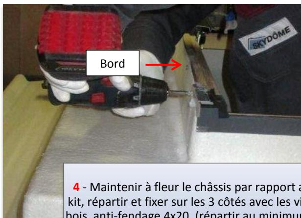
**4** - Maintenir à fleur le châssis par rapport au kit, répartir et fixer sur les 3 côtés avec les vis à bois anti-fendage 4x20 (répartir au minimum 3 fixations par mètre à environ 20 mm du bord de l'adaptation polyester)
