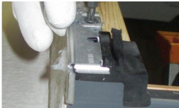
**7 - Fixer cette pièce avec les vis fournies avec la fenêtre de toit (voir notice de pose fenêtre de toit)**
