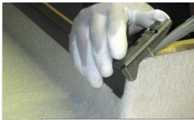
**6** - Lever la pièce et poser du mastic polyuréthane sur les côtes lateraux et le haut du dormant (voir images ci-dessous).
