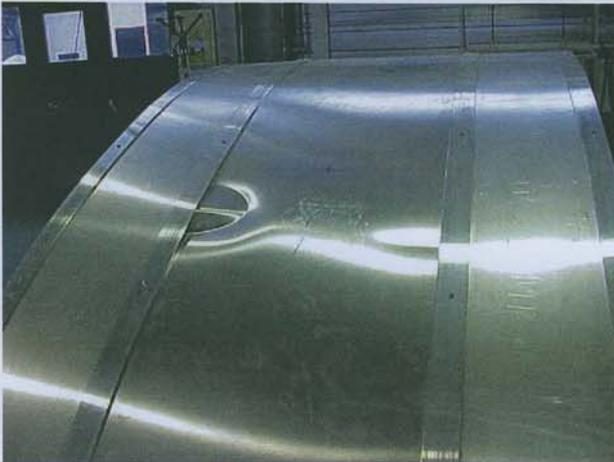
On observe une déformation du remplissage central au droit des couvres – joints et arceaux, sans incidence sur les remplissages périphériques.
