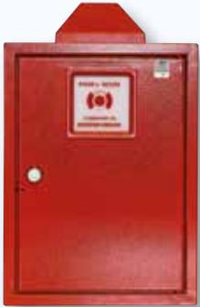
Los cuadros de control neumáticos con CO<sub>2</sub> para evacuación de humos **bizona** accionan los exutorios mediante activación manual (apertura y cierre). Permiten la apertura simultánea de 2 zonas de evacuación de humos mediante una simple acción sobre un pulsador. El cierre de las 2 zonas se lleva a cabo también mediante pulsador.
