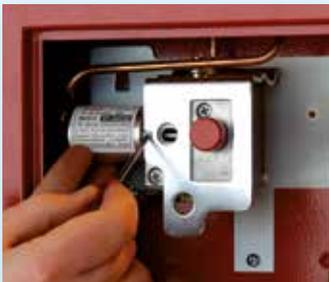
Los cuadros de control neumáticos con CO<sub>2</sub> para evacuación de humos **simple zona**, y con función **ventilación confort** accionan los exutorios mediante activación manual (apertura por CO<sub>2</sub> y cierre por aire comprimido).
